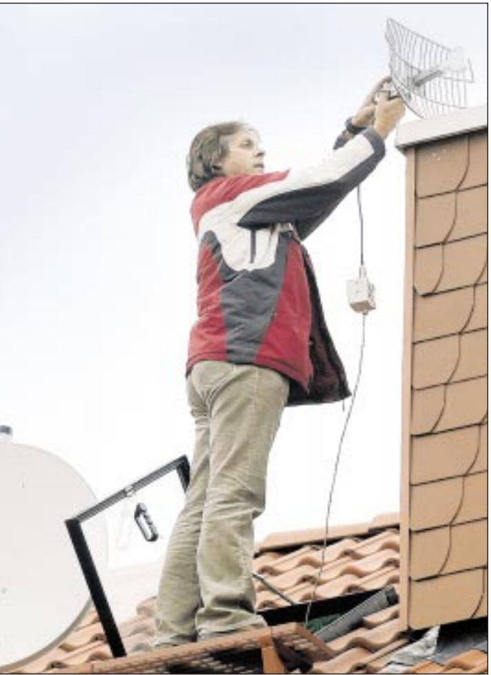
Angepeilt: Peter Wieland, Vorsitzender des Vereins Stadtnetz- und Internetfreunde Viernheim, misst auf einem Dach im Lorsche Neubaugebiet Viehweide die Signalstärke für das Stadtnetz Lorsch. Per Richtfunk können Nutzer auf diesem Weg ins Internet. FOTO: KARL-HEINZ KÖPPNER
